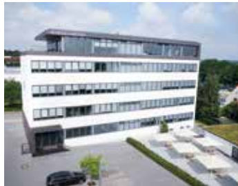
Verwaltungsgebäude am Hauptsitz in Herford.
